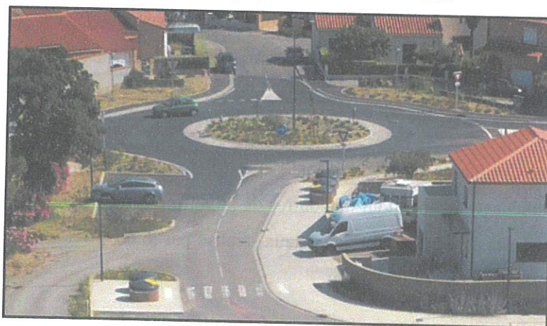
Figure 16 : Photographie du rond-point réalisé
