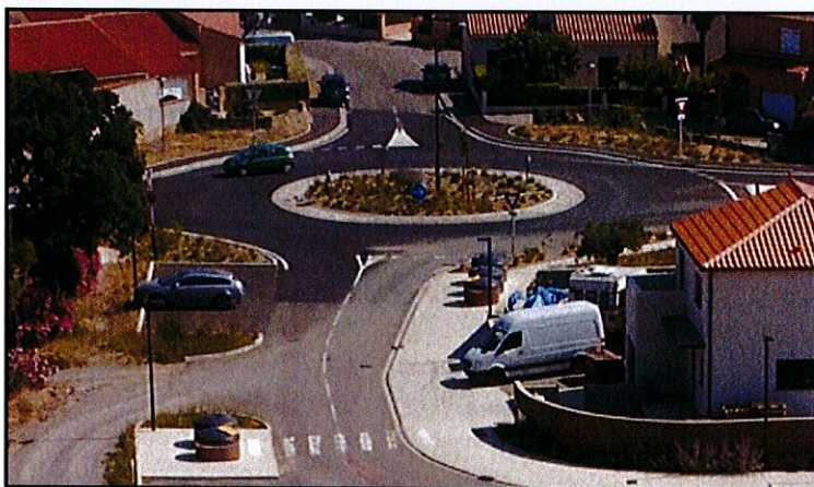
Figure 17 : Photographie du rond-point réalisé
